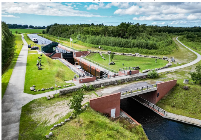
Foto BHM Drone
